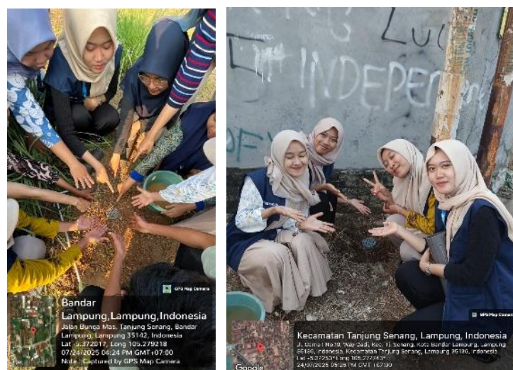
Gambar C.1 Pembuatan Lubang Resapan Air
